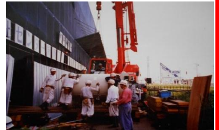
建設中の様子
